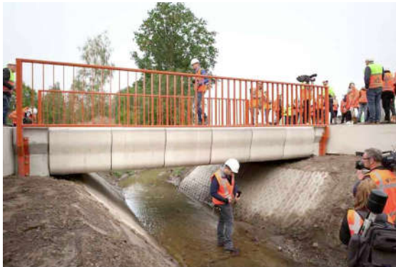
Cầu đi xe đạp đầu tiên trên thế giới được in bằng bê tông
